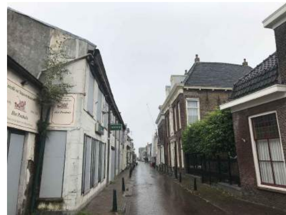
straatbeeld Dorpsstraat vanuit zuidelijke richting
